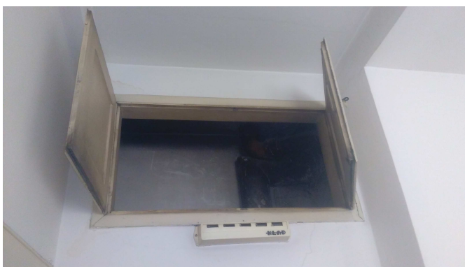
Obr.č.14 – Okno v koupelně do instalační šachty
