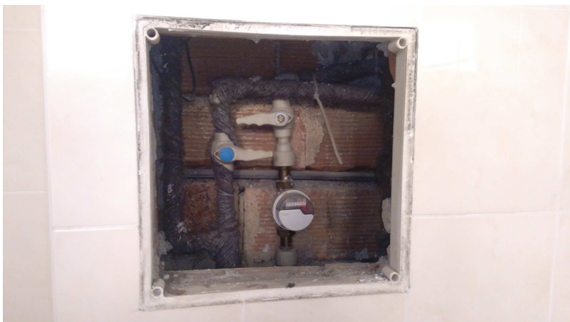
Obr.č.16 – Vodoměr v koupelně
